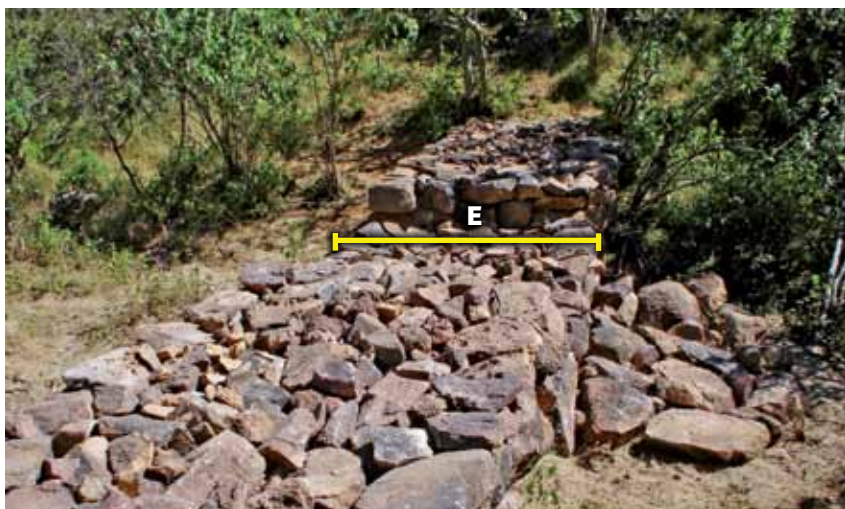
Foto 11. Espesor de una presa.
