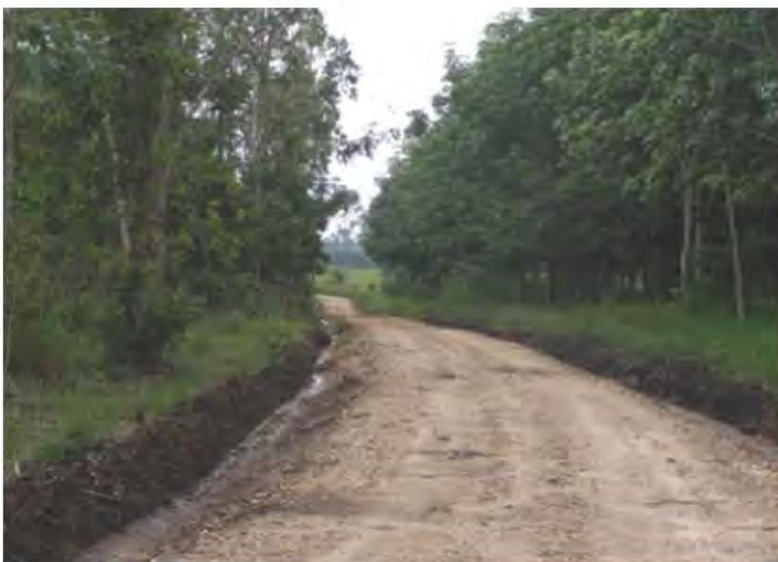
Figura 136. Camino de extracción en una plantación de eucalipto (*Eucalyptus urograndis*), combinada con hule (*Hevea brasiliensis*) en Huimanguillo, Tabasco. La empresa “Forestales Mexicanos”, tiene un nivel alto de inversión en infraestructura caminera. Nótense las cunetas a ambos lados y la incorporación de material de revestimiento.
