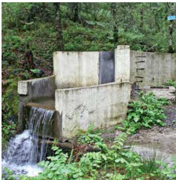
Sistema de mangueras a distintas alturas para captar los sedimentos en suspensión.
