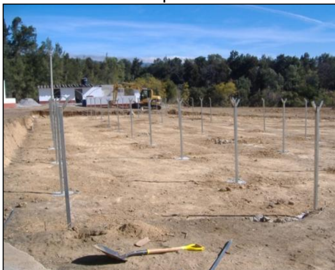
Instalación de soportes verticales
