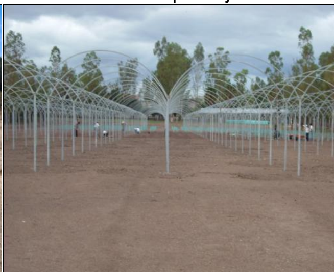
Instalación de arcos superiores y cableado
