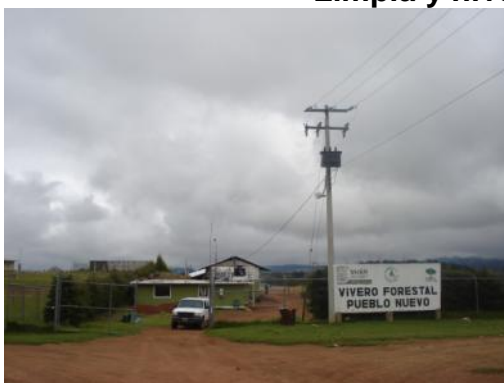
Toma de energía eléctrica
