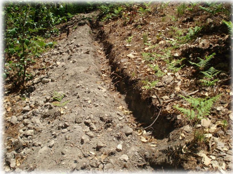
Figura 15.- Obras de conservación de suelos en la Umafor
