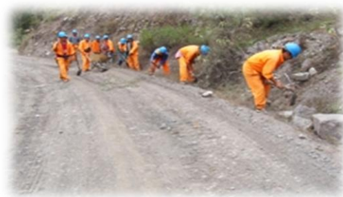
Fig. 11 Mantenimiento de caminos
