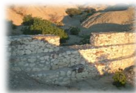
Fig. 7 Presa de gaviones en cárcava
