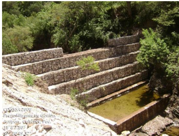
COUSSA 2008 Presas Filtrante de Gavión. Guadalupe la mesa, Zapotitlán Salinas, Pue. 18° 9' 59.76" 97° 31' 36.84"
