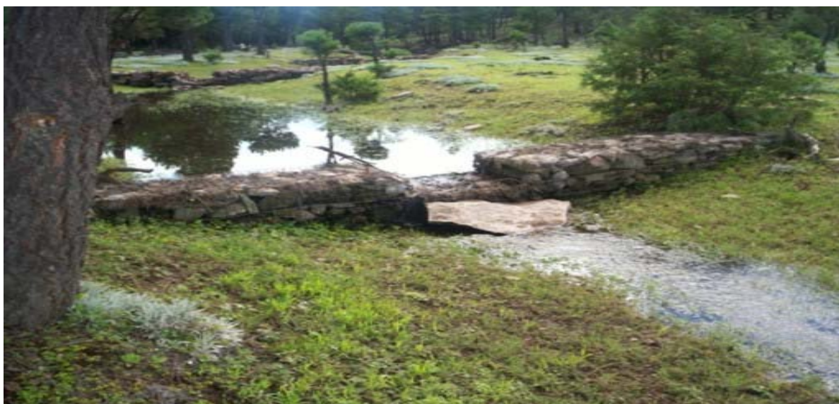
Figura 18. Presa con malla para retener suelo en arroyos. Cortesía: Ing. Emilio García L.
