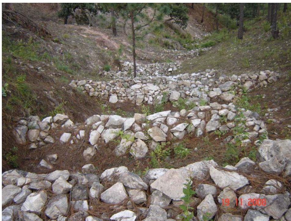
Figura 29.- Obras de conservación de suelos en la Umafor
